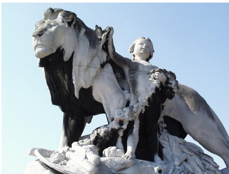
FIGURE 38 : IMPACT DE LA POLLUTION ATMOSPHÉRIQUE SUR LES MATÉRIAUX
